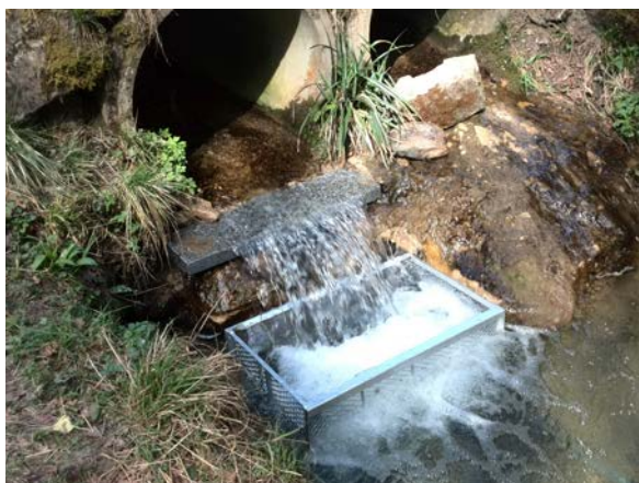
Abbildung 2-1: Hier ist der Netzkorb im Schalchmatthaubächli unterhalb der Dolung abgebildet. Bei normalem Abfluss fließt der Bach durch den Fangkorb (Quelle: David Bittner).
