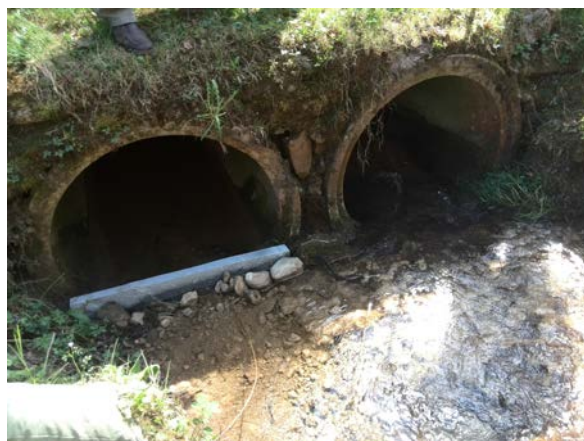
Abbildung 2-2: Oberhalb der Installation wurde eine Röhre der Dolung versiegelt. (Quelle: David Bittner)
