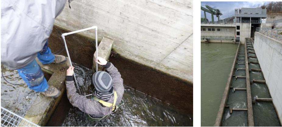
**Abbildung 2:** Links: Montage einer Antenne im Schlitz. Rechts: Vertical-Slot Pass.
