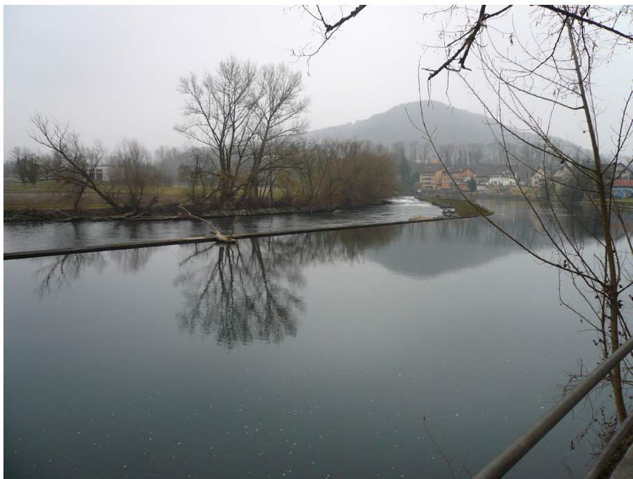
Abbildung 24: Staubereich und Streichwehr mit Restwasserstrecke des Krafwerks BAG im Februar 2011.
