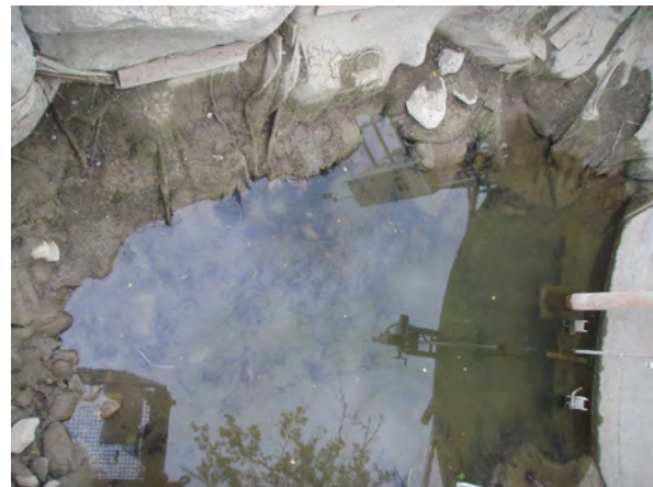
Abbildung 22: Die Fischschleuse wurde beim Hochwasser vom 1.5.2015 teilweise mit Schlamm angefüllt.
