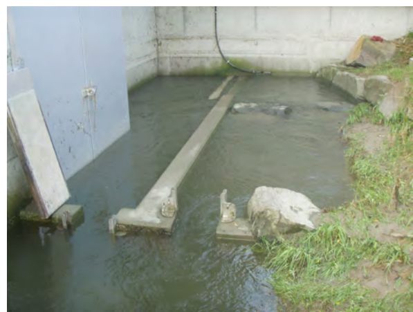
Abbildung 10: Zählbecken der FAH KW Hirschthal am 26. Juni 2016 bei einem Abfluss der Suhre von 8.3 \text{ m}^3/\text{s} (Tagesmittelwert).
