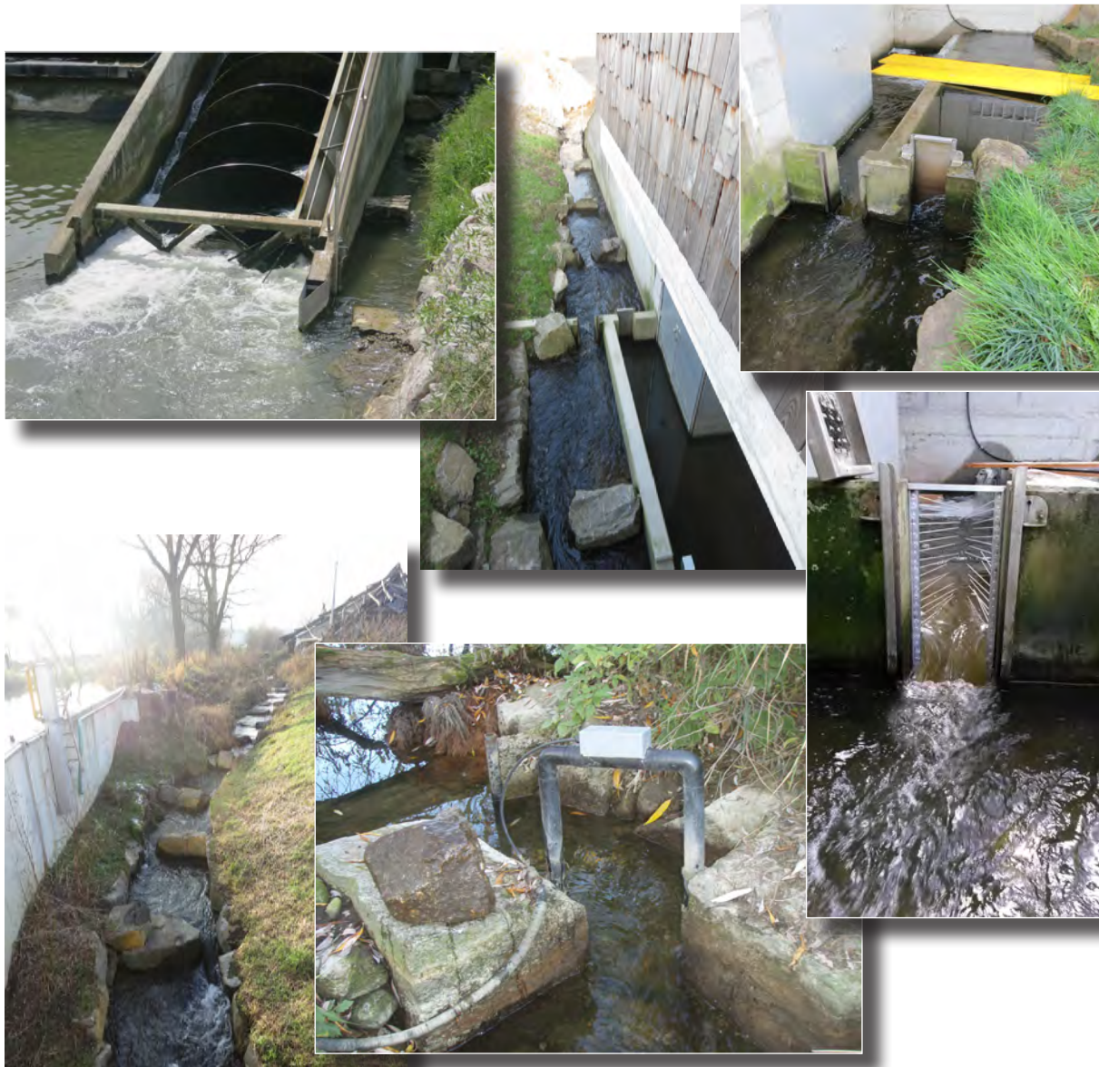
Abbildung 6: Fischpass beim KW Hirschthal (im Uhrzeigersinn: Einstieg, unterster Abschnitt beim Zählbecken, Zählbecken in Betrieb, Einstieg ins Zählbecken, oberer Abschnitt, 2. oberster Schlitz mit eingebauter RFID-Antenne).
