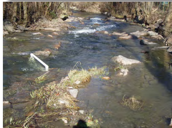
Abbildung 19: RFID-Antennen im Umgehungsgewässer des WWKW Schöffland, oben nach dem Hochwasser vom 1.5.2015, unten nach der Neuinstallation und Wiederaufnahme des Betriebes im September 2015.
