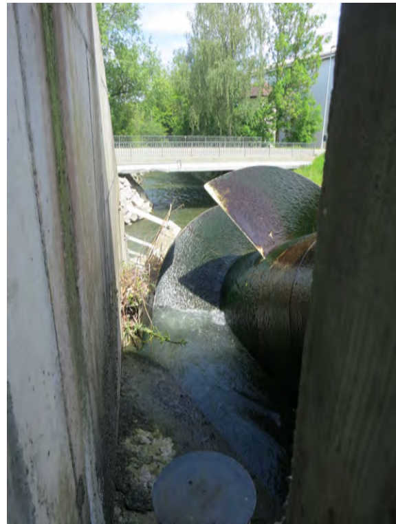
Abbildung 14: Einsteig zur FAH des KW Hirschthal am 7.11.2015 bei einem Abfluss von 0.445 m 3 /s und KW stillstehend.
