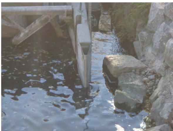
Abbildung 15: Einstieg zur FAH des KW Hirschthal am 7.11.2015 bei einem Abfluss von 0.445 m 3 /s und KW stillstehend.
