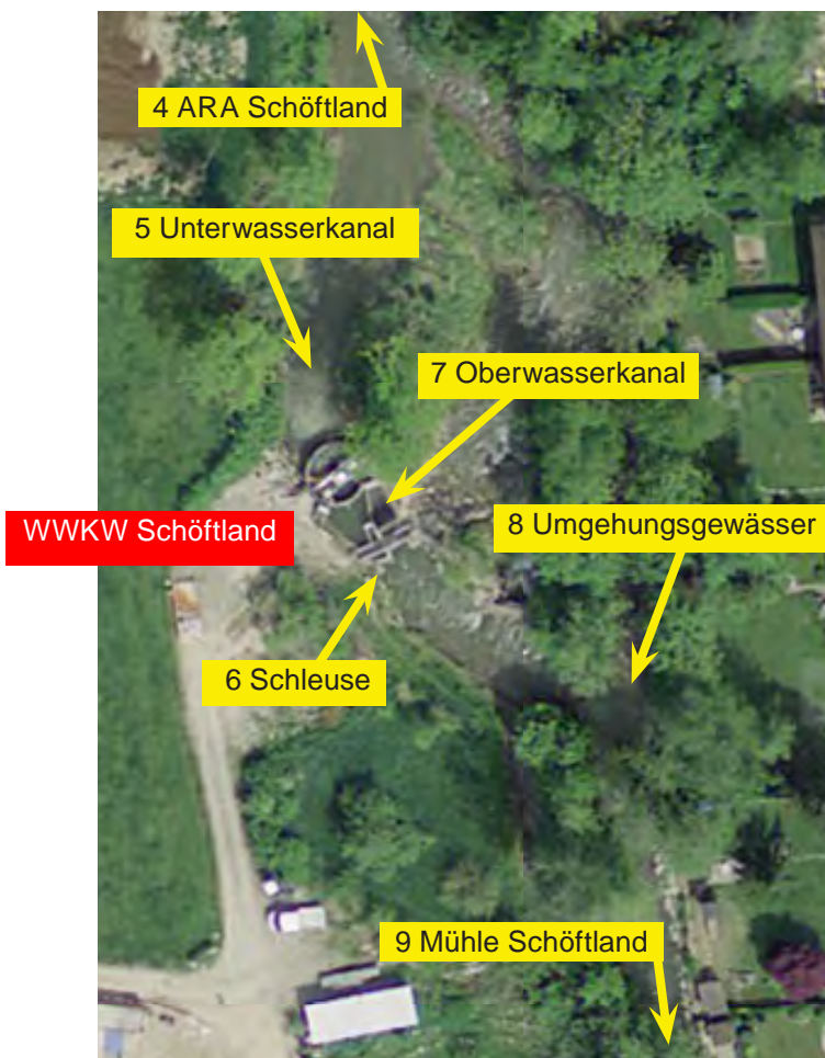
Abbildung 17: Situation und Lage der RFID-Antennen beim WWKW Schöffland und nächstgelegene Antennen in der Suhre. Die Nummern 4 - 9 beziehen sich auf die Antennennummern gemäss Kapitel 2.
