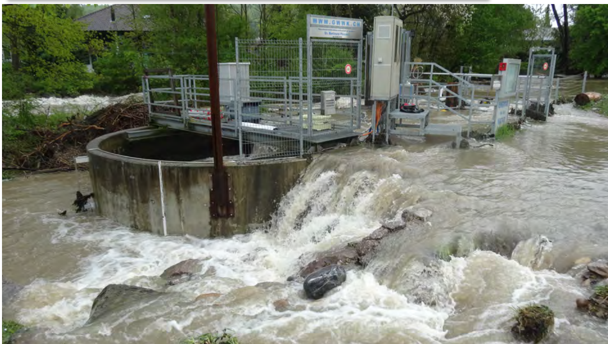
Abbildung 21: Hochwasser vom 1. Mai 2015 das WWKW wird überflutet und verschiedene Teile werden beschädigt.
