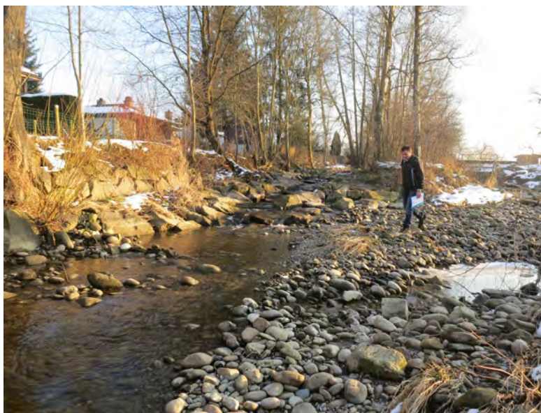
Abbildung 23: Unterster Abschnitt und Mündungsbereich des Umgehungsgewässers bei Niederwasser im Februar 2015.
