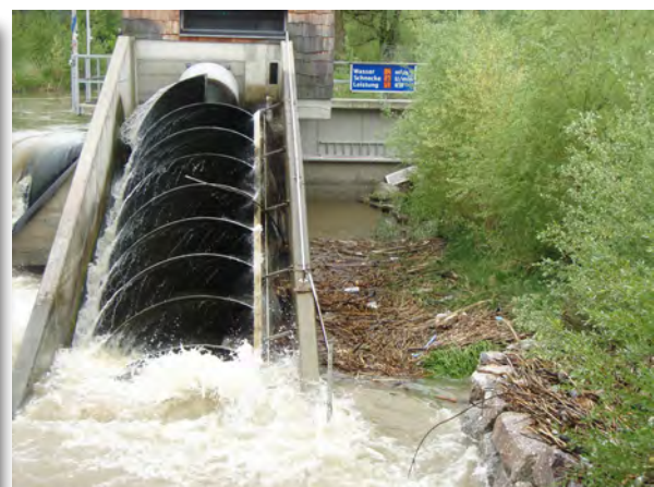
Abbildung 16: Einstieg zur FAH des KW Hirschthal am 6.5.2015 bei einem Abfluss von >3 m 3 /s.
